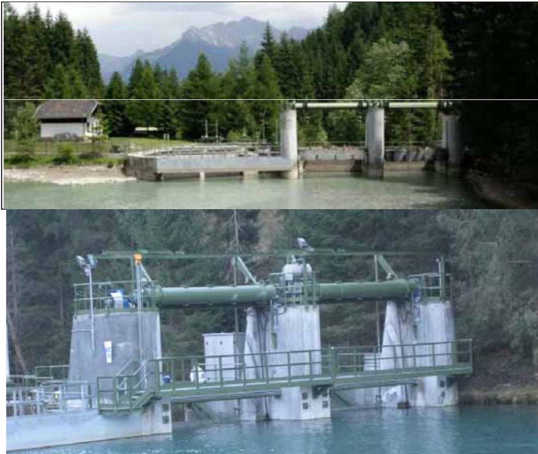
nuove paratoie a settore con ventola automatica a bilanciere a fulcro variabile e asservimento oleodinamico automatico
